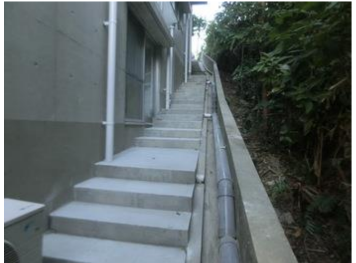
写真は、2年ほど前の工事直後のもの
